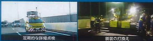
定期的な詳細点検
