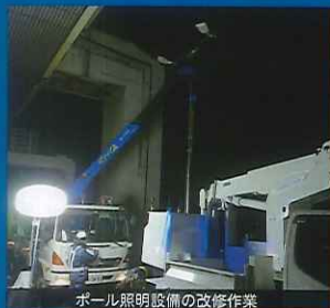
ポール照明設備の改修作業
