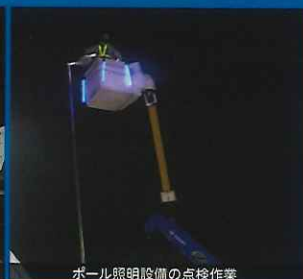
ポール照明設備の点検作業
