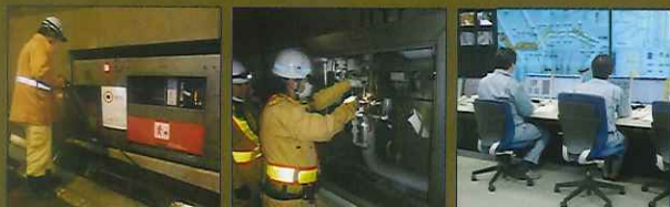
泡消火栓点検
