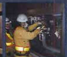
水噴霧装置点検
