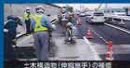
土木構造物(伸縮継手)の補修
