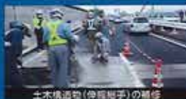
土木構造物(伸縮継手)の補修
