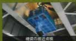
橋梁の接近点検
