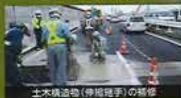
土木構造物(伸縮継手)の補修
