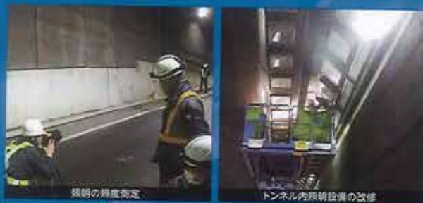
トンネル内照明設備の改修
