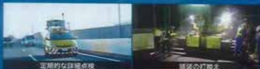
定期的な詳細点検
